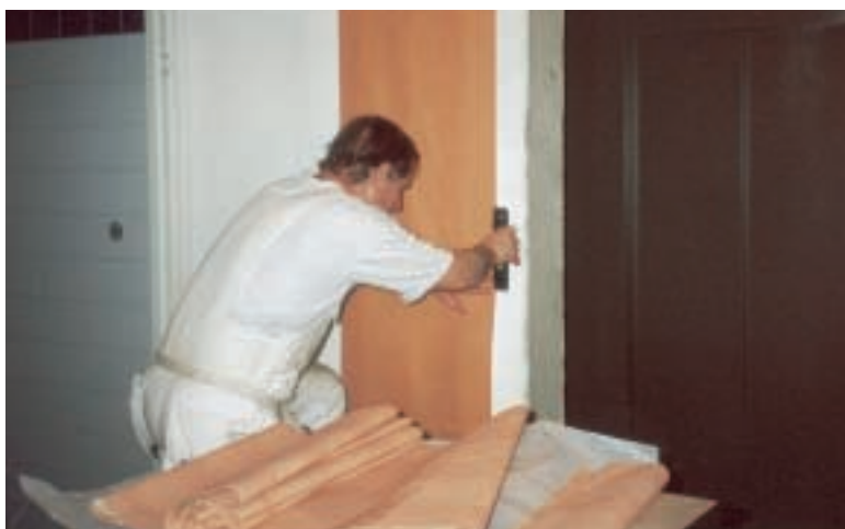
Målare från Målerifirma L. Åkerlund tapetserar på nybygge i Frösunda. Foto: Tony Öberg
